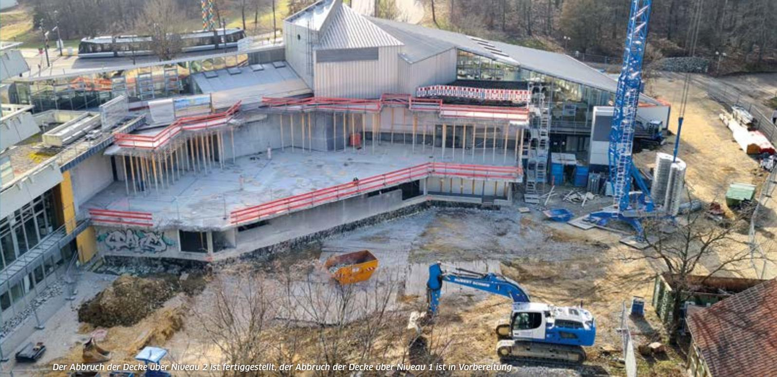
Der Abbruch der Decke über Niveau 2 ist fertiggestellt, der Abbruch der Decke über Niveau 1 ist in Vorbereitung
