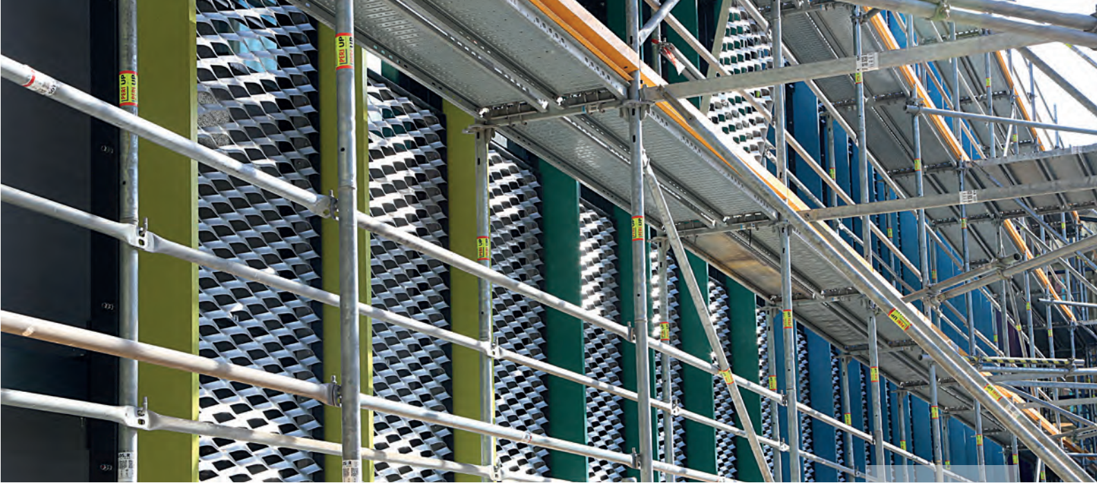
Fassade der Mensa Uni Süd im Bau
